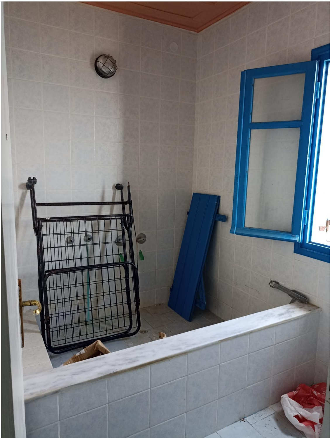
Ατομικό λουτρό ορόφου
