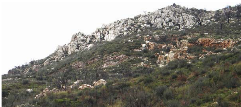
Εικ. 2 Πτώσεις βράχων στη θέση κατολισθήσεων Δερβένι ανάντι της Ε65.
