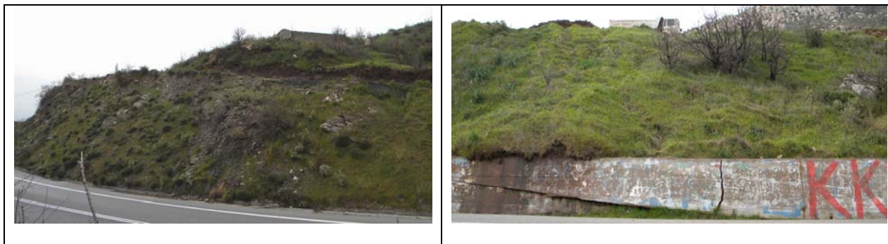
Εικ. 1 Δύο διαφορετικές εικόνες της κατολίσθησης παρά το Δερβένι ανάντι της Ε65
