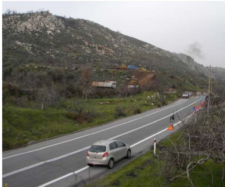
Εικ. 3 Γενική άποψη της κατολίσθησης. Στην εικόνα φαίνονται διαρρήξεις στο οδόστρωμα, το γεωτρώπανο, τα χωματουργικά μηχανήματα και οι μάζα της κατολίσθησης.
