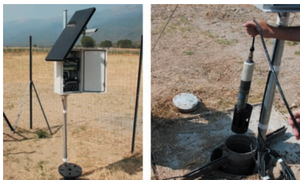
Ερευνητική γεώτρηση στο Δαφνούδι Σερρών με εγκατεστημένο σύστημα τηλεμετρίας για τη μετάδοση δεδομένων
