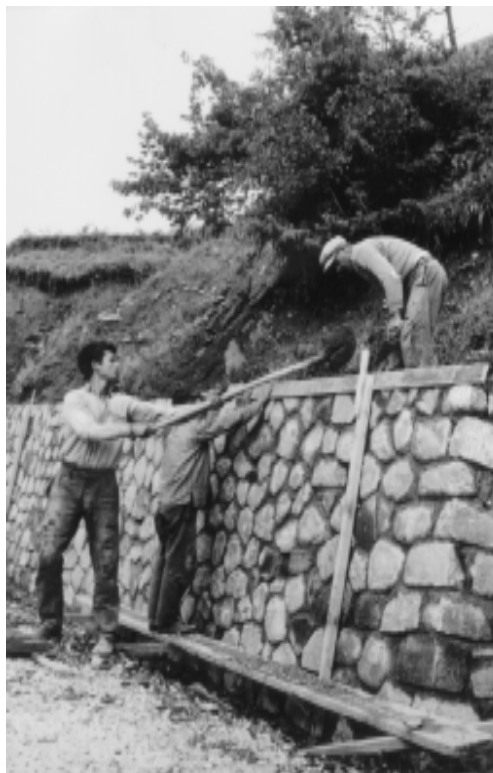
Λιθόκτιστος τοίχος αντιστήριξης
