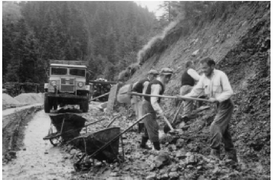
Διαμόρφωση πρανών δασικής οδού - ήπια επέμβαση στο απότομο ανάγλυφο της περιοχής
